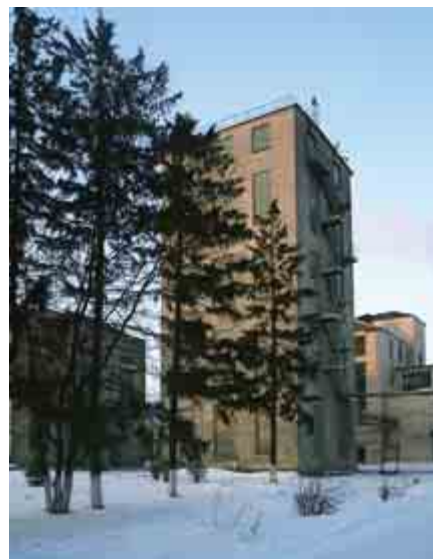
Козловский спиртовой завод, здание брагоректификационной установки
